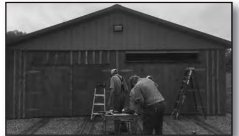
Installing Door Trim
